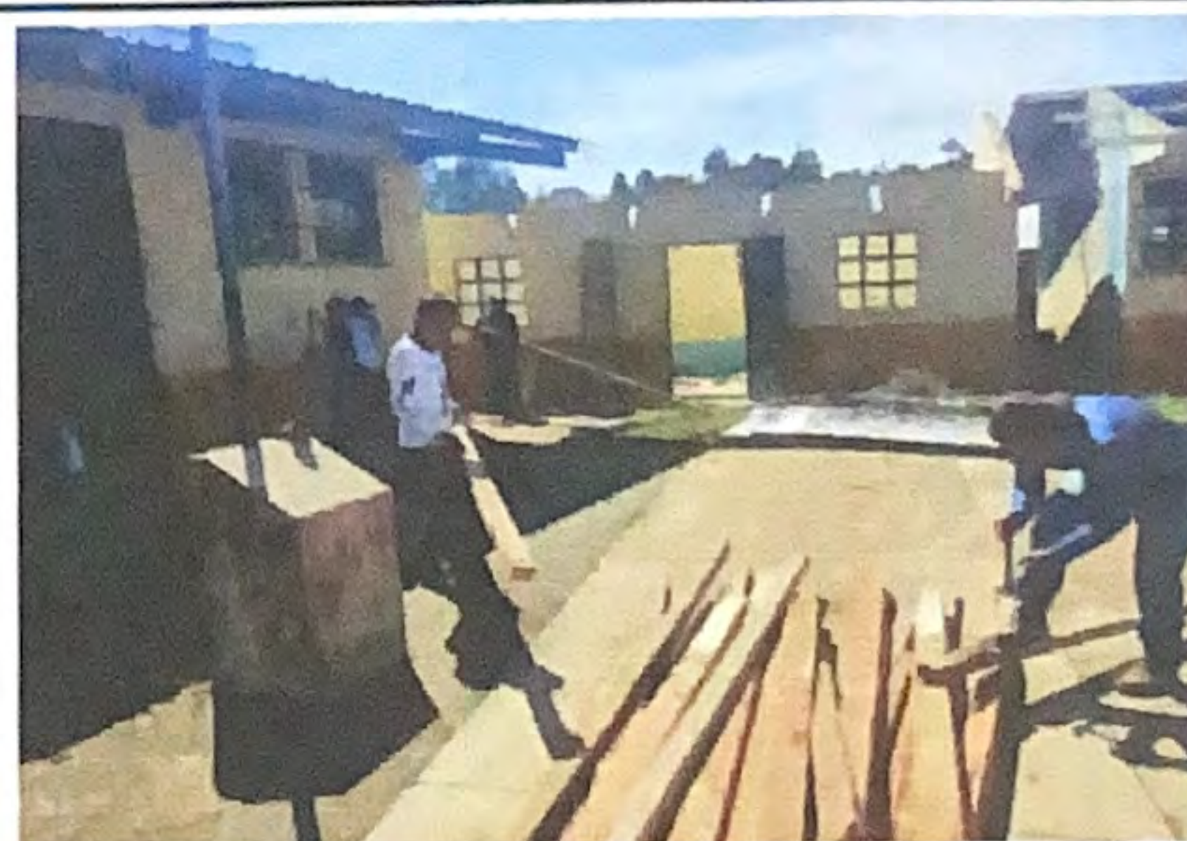
Foto 6: Quitando las vigas de las aulas.
