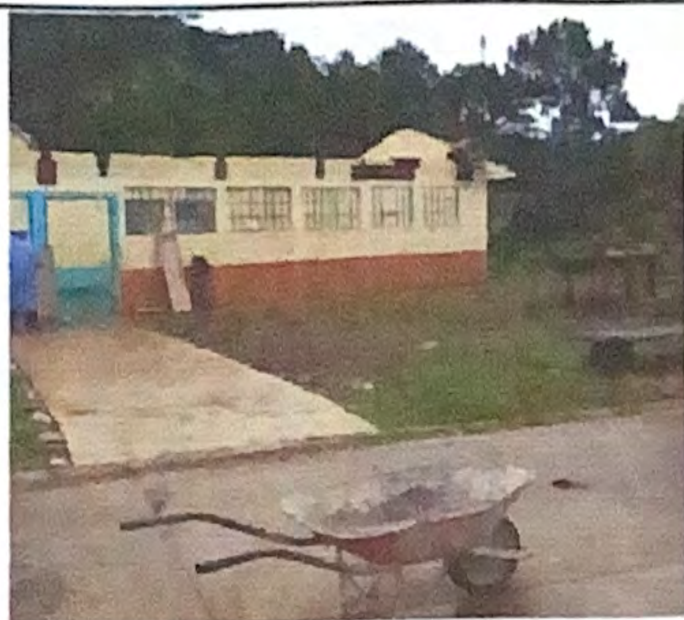
Foto 1: Se quito las vigas y laminas.
