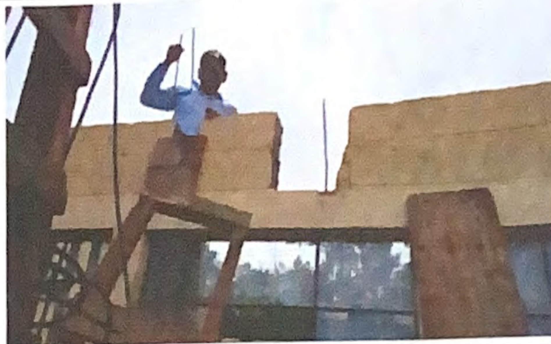
Foto 2: Fundir el lugar de la costanera
